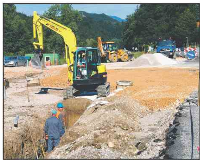
Pripravljalna dela za izgradnjo krožišča v Trebuši so že stekla.
