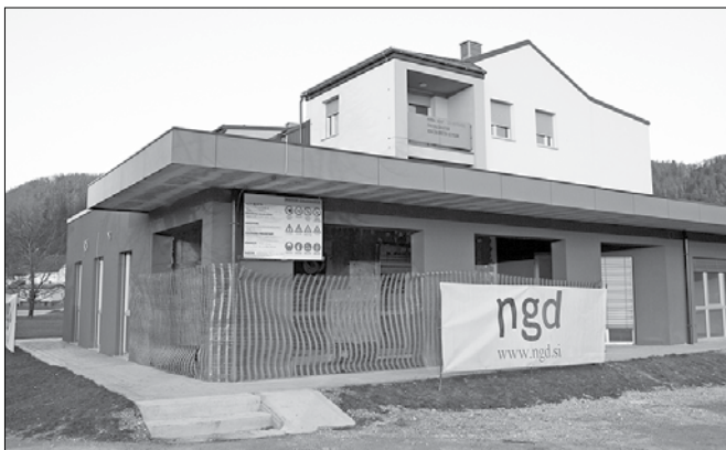
Nova lekarna bo v stanovanjsko poslovnem objektu v centru Nazarj.
