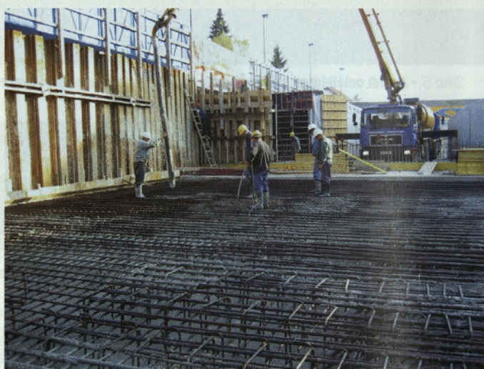
Slika 11 • Betoniranje pokrova pokritega vkopa
