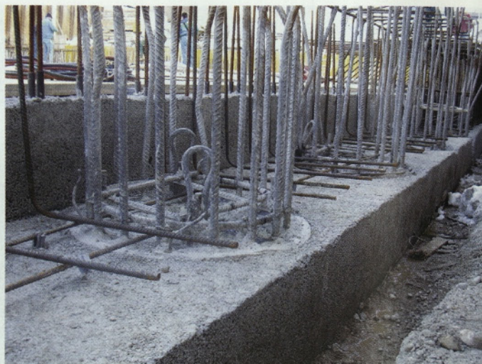
Slika 9 • Glave pilotov pod robnim vencem med montažo stremen robnega venca
