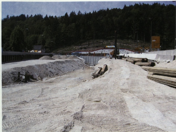
Slika 15 • Nasipi priključnih klančin
