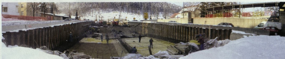
Slika 6 • Gradnja je potekala brez zastojev kljub neugodnim vremenskim razmeram
