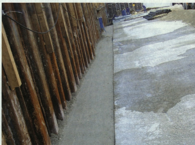
Slika 13 • Zaščitni beton nad hidroizolacijo pokrova in zasip med jeklenimi zagatnicami in pokrovom
