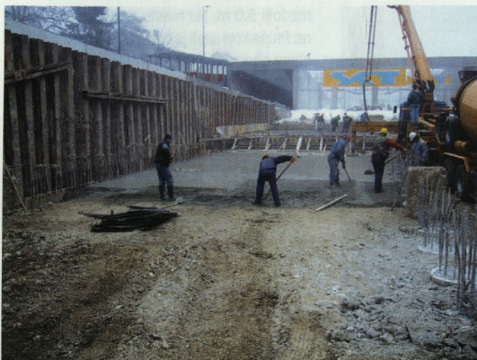
Slika 8 • Zaradi razmočenosti tal je bil ponekod potreben debelejši podložni beton
