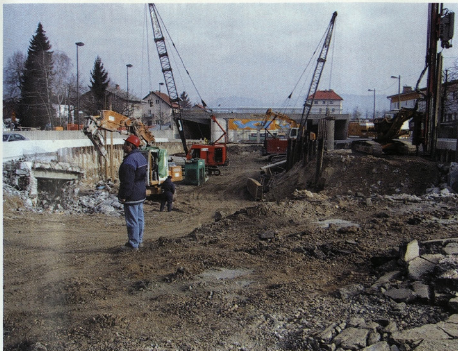
Slika 5 • Zaradi omejenega prostora je bilo treba izvesti premišljeno organizacijo gradbišča
