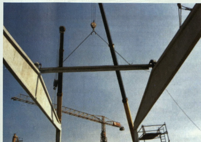
Slika 7 • Demontaža sekundarnega nosilca brez jarma
