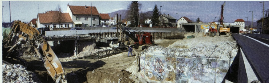
Slika 7 • Rušenje obstoječega podhoda Prušnikove ulice v gradbeni jami, zaščiteni z jeklenimi zagatnicami
