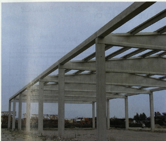
Slika 1 • Primer armiranobetonske hale iz programa SGP Konstruktor
