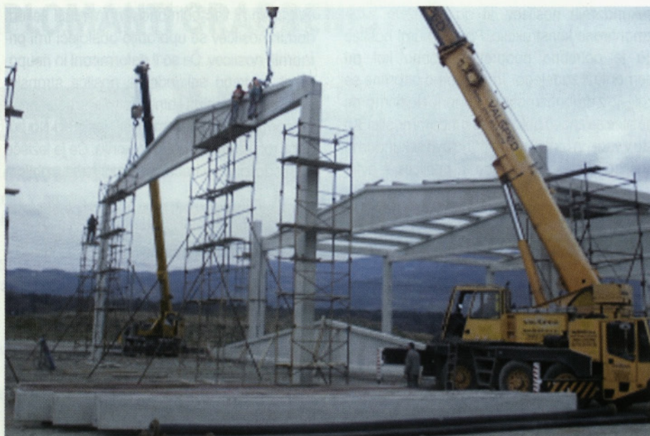
Slika 10 • Demontaža primarnega nosilca, varovalni odri in deponija korit
