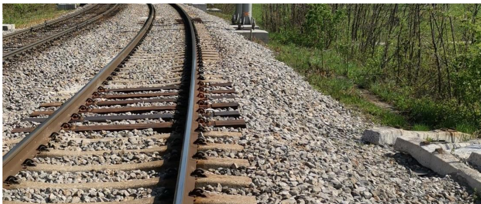
Slika 13: Zamenjava na spodnjem delu abrazijsko in mehansko poškodovanih PŽP-MAB z lesenimi pragovi.
