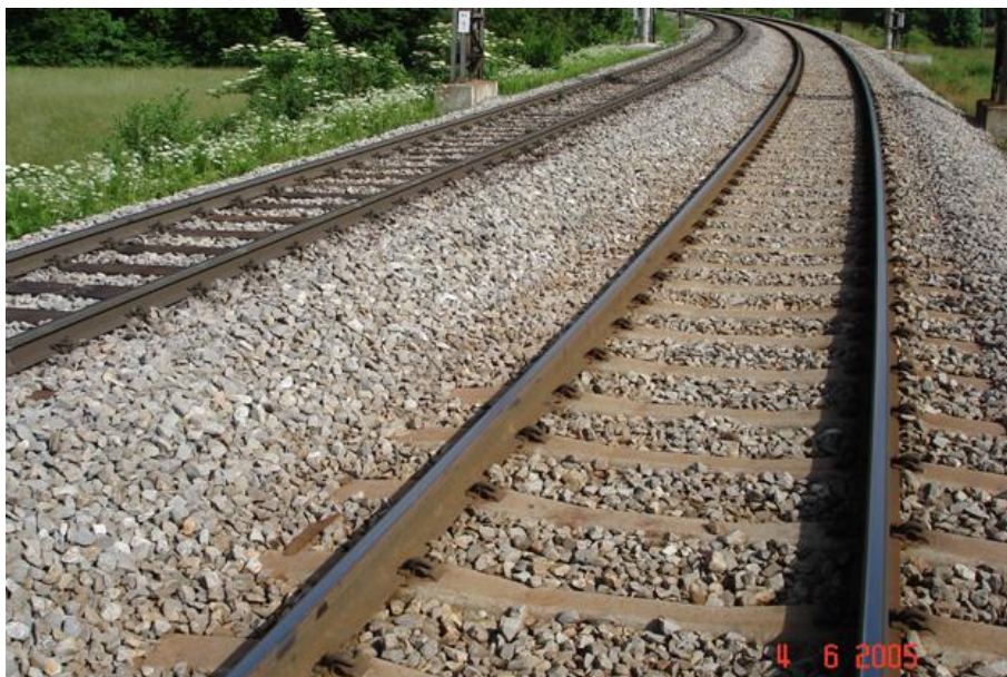
Slika 9: Grajeni PŽP-MAB po 9 letni uporabi. Posneto v smeri Postojna, v obratni smeri vožnje vlakov
