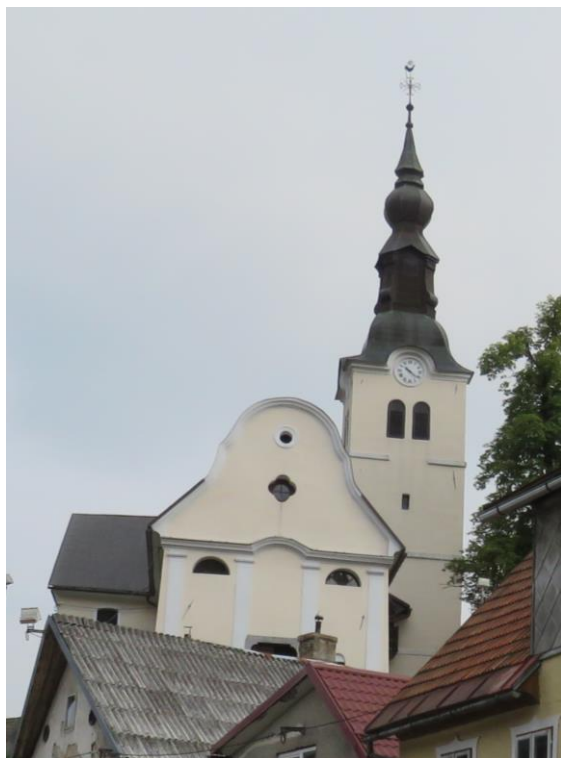
Slika 108: Pogled s trga na vhodno fasado cerkve v Čabru, vrata so žal zakrita s strehami.
