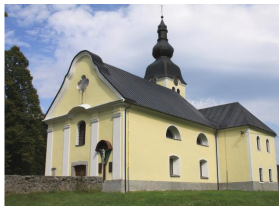
Slika 109: Vhodna fasada cerkve v Dragi pri Loškem Potoku se le malo razlikuje od tiste iz Čabra. Streha zvonika je podobne oblike kot je bila nekdanj na zvoniku v Plešcih.
