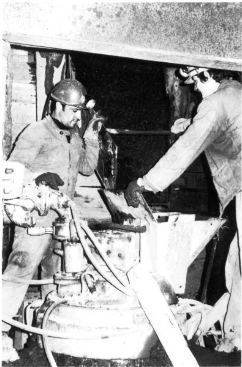
DELO PRI ZAPIHOVALNEM KOTLIČKU PRI SLEPEM JAŠKU KARBON NA 3. OBZORJU
