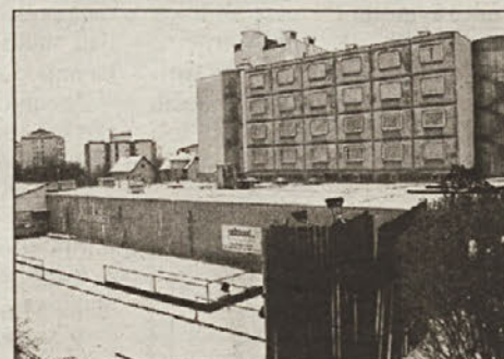
Neizkoriščeno keglijšče in balinišče - prostor za parkirno hišo
