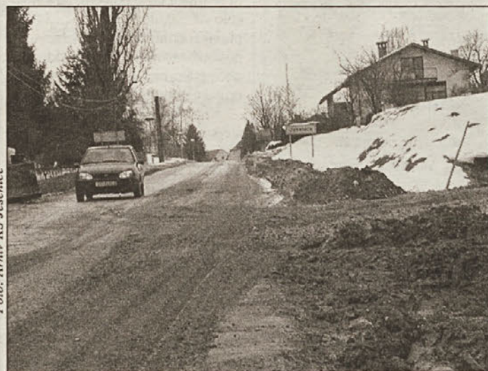
Pri deponiji na Jesenicah so kamioni cesto spremenili v preorano njivo.
