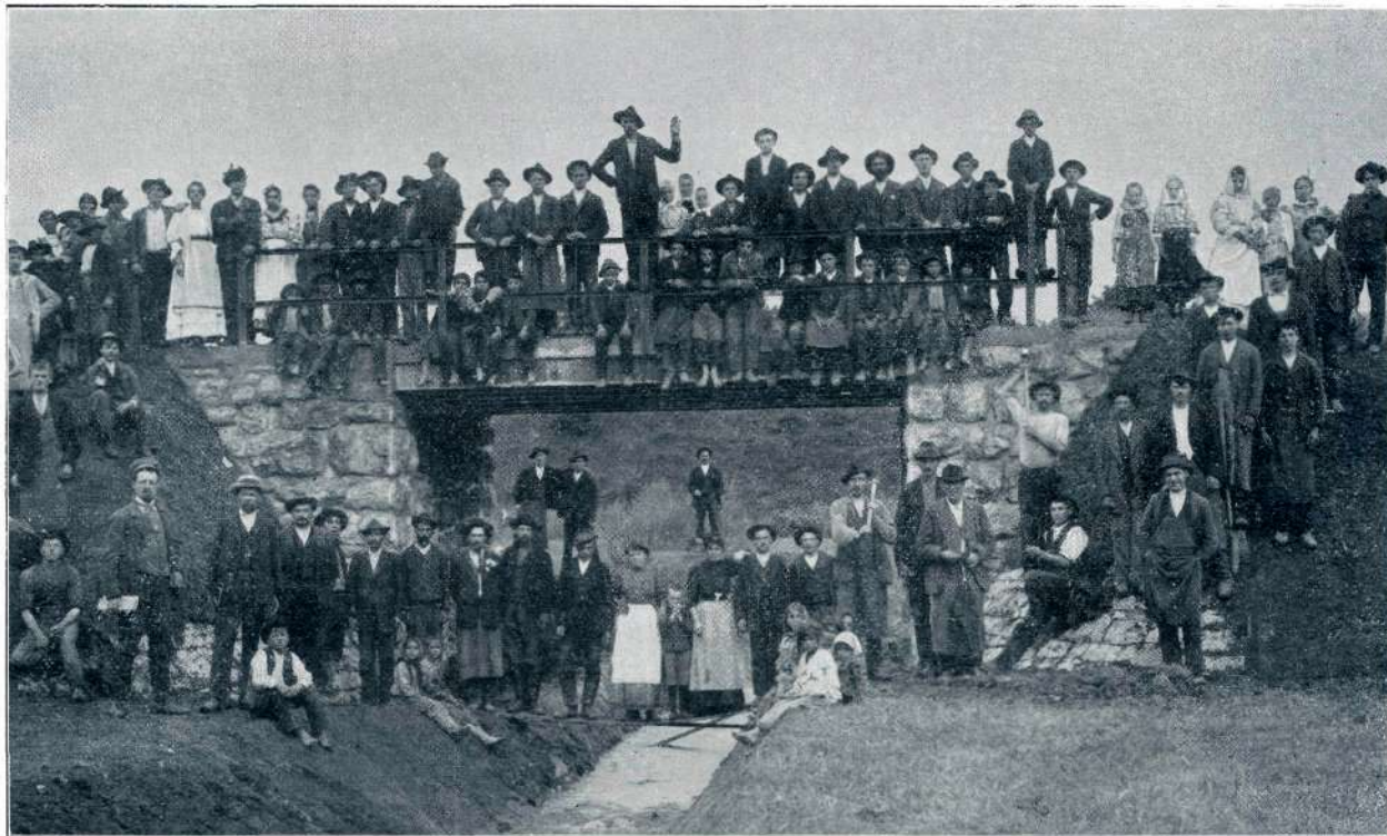
„MOST DELAMO!“ Od zgradbe na cesti Muljava—Gabrovščica. (Fot. J. Erjavec.)
