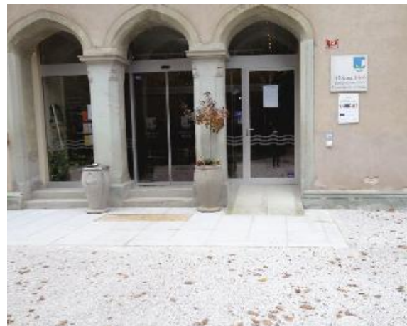
Novo urejeno dvorišče občinske stavbe, vile Zora – po na novo urejeni hidroizolaciji in ogrevalnem sistemu.
