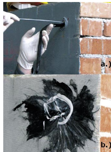
Slika 7 • Vgrajevanje karbonskih sider: a.) vstavljanje sider v luknjo, b.) razširitev vlaken pred nanosom matrike
