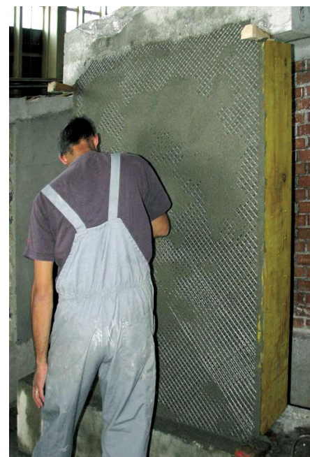
Slika 6 • Diagonalno postavljena GFRP-mreža in nanašanje cementne malte
