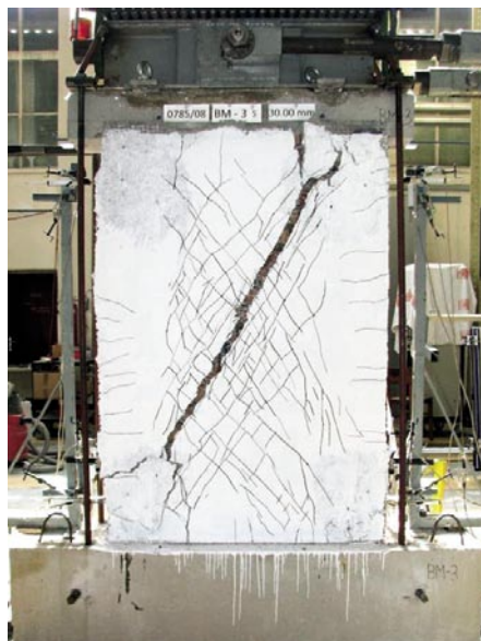
Slika 17 • Poševno usmerjene razpoke v osrednjem delu zidu in natezne razpoke v robnih ojačitvah (utrditev tipa 7)
