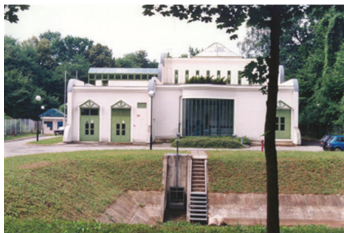
Slika 23 • Čistilna naprava za odstranitev peska, za eliminacijo Mn^{2+} in Fe^{2+} in ozračje vode pred infiltracijo preko nalivalnih vodnjakov v podtalnico na vodarni Vrbanski plato.
