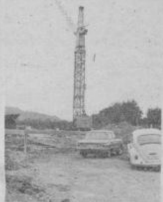
Gradbišče nove trgovine na Vidmu z ogromnim žerjavom.
