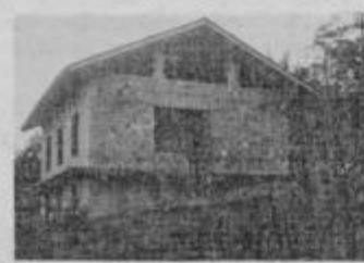
Lovski dom je že pod streho.
