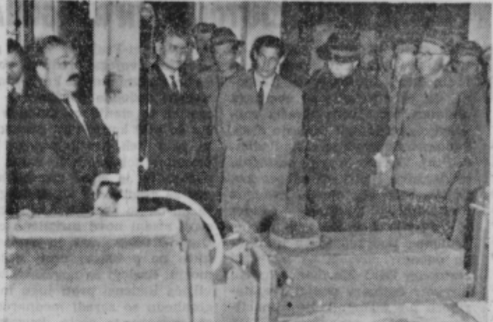
Ob otvoritvi rekonstruiranega obrata opekarne Ormož
