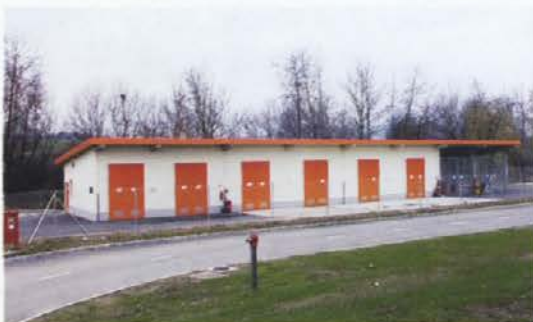
Novo skladišče nevarnih kemikalij v Straži
