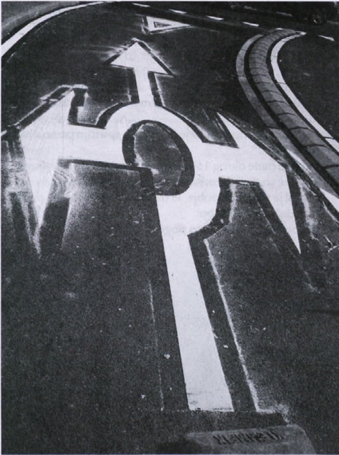
Prometni pasovi so med seboj fizično ločeni z delineatorjem, ki je visok 7 cm.
