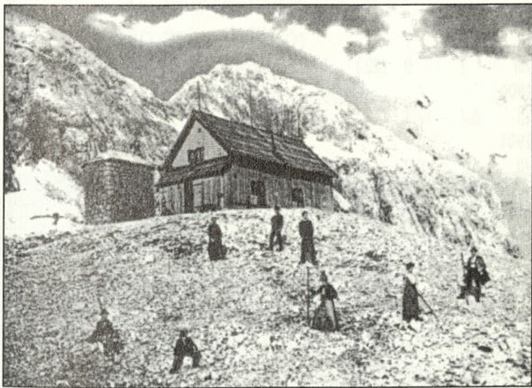
Prva koča na Kredarici (zgrajena 1896)
