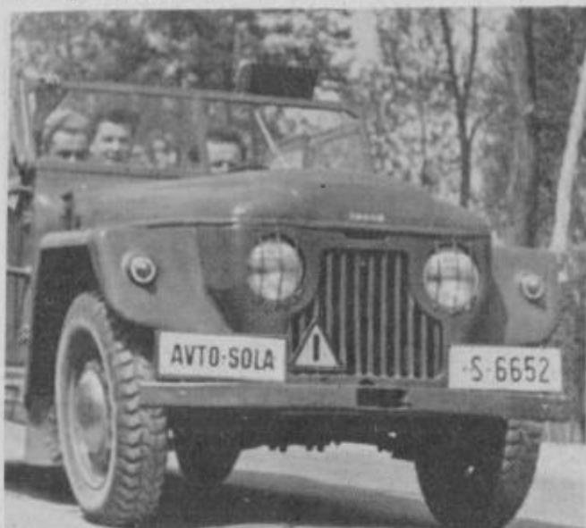
Pred 16 leti so se ptujski vozniki učili voziti na takšnih vozilih. Za obvladanje vozila je bilo takrat potrebno pokazati mnogo več truda in znanja kakor danes. Mehanizem vozil je bil robot, pravtako še takrat menjalniki niso bili sinhronizirani.
