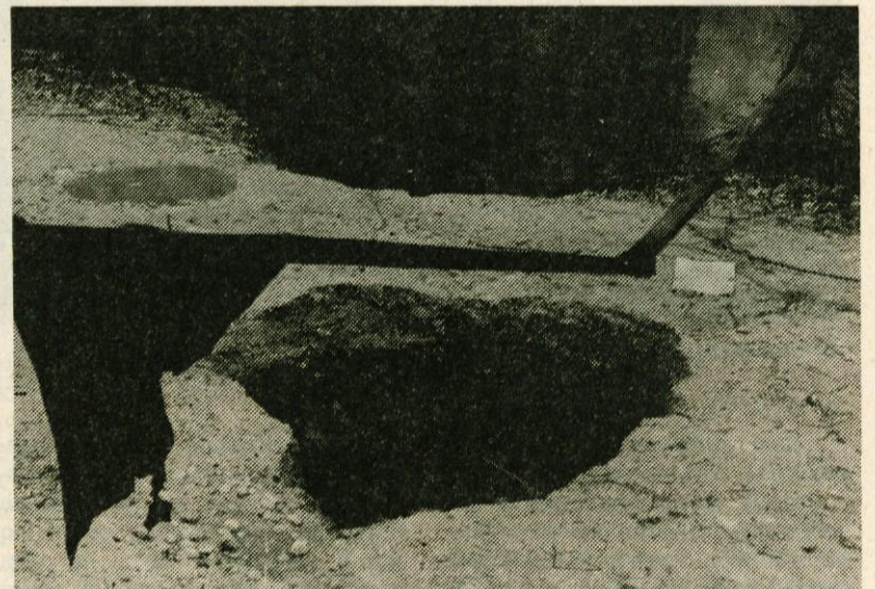
Zadnje deževje je povzročilo, da je del ceste od Doba proti Gorjuši enostavno izginil
