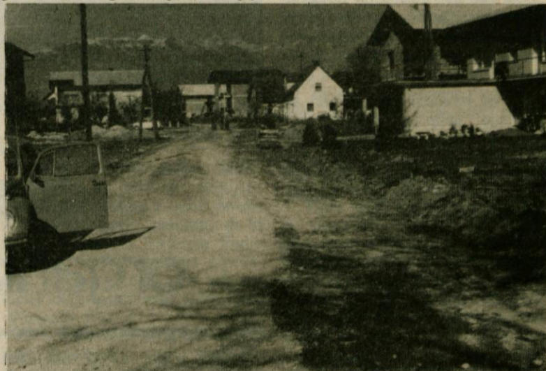
Dolgo časa je bilo vprašanje cest na območju „Sever – 1“ odprto. V zadnjem času tudi te ceste dobivajo asfaltno prevleko
