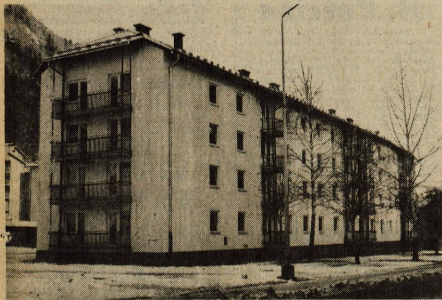
Z obnovo starih »železniških« blokov na Plavžu na Jesenici so pridobili več novih, manjših sicer, a bolj funkcionalnih stanovanj. — Foto: F. Perdan
