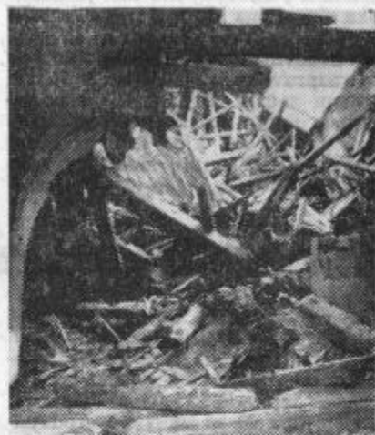
Tak je pogled na razpadlo grajsko pristavo Ojstrica, ko je neki zasebnik porušil nosilni stolp, da bi prišel do gradbenega materiala.
