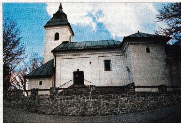
...in po sanaciji, ki jo je opravilo Pelkovo podjetje.
