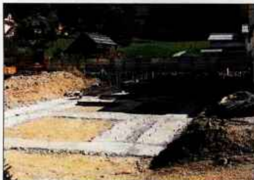
Pri žirovniški šoli so začeli graditi večnamensko dvorano.
