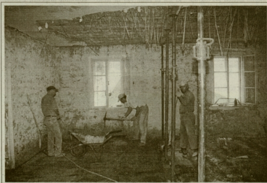
Za prenovitvena in adaptacijska dela na trškem kulturno-zgodovinskem spomeniku, stanovanjski stavbi na Glavnem trgu 17, je bilo izbrano Gradbeništvo Božičnik. »Izbrali smo najugodnejšega ponudnika,« pravi Sotlar in dodaja, da sodijo med julijska gradbena dela ojačitev temeljev iz notranjosti kletnih prostorov ter odstranitev ometov v celotni stavbi.
