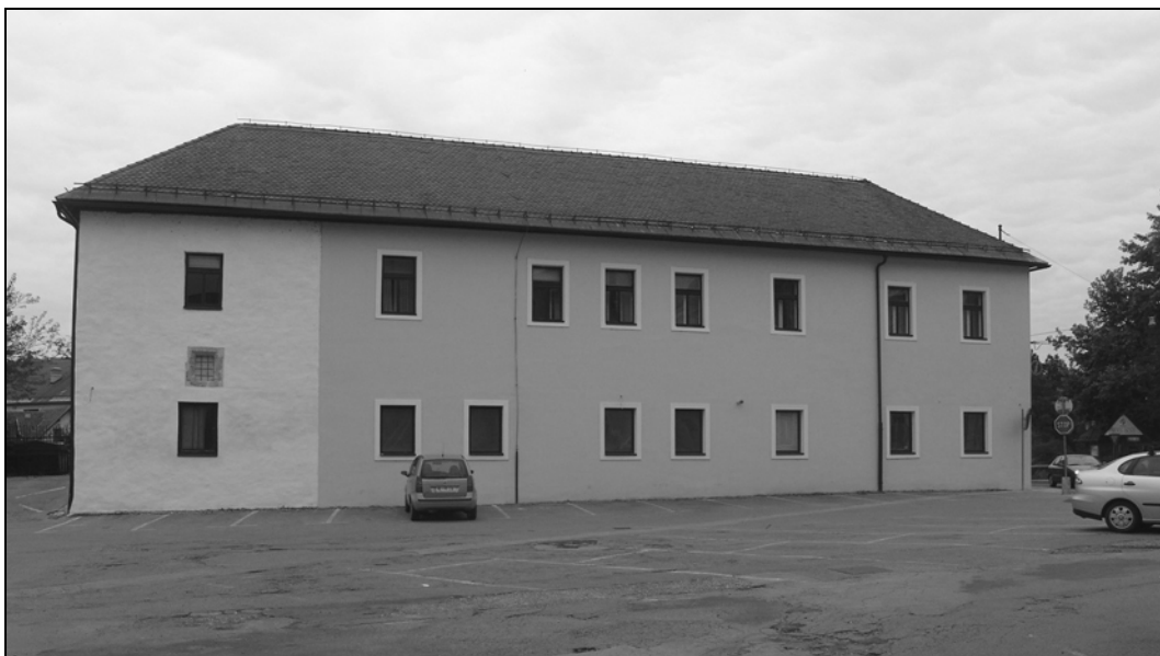
Južni trakt črnomaljskega gradu z nekdanjim vogalnim stolpom (foto: Igor Sapač).
