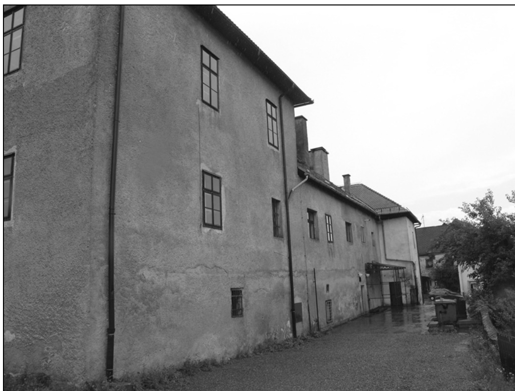
Severozahodni vogal črnomaljskega gradu z ostankom nekdanjega osrednjega stolpa (foto: Igor Sapač).
