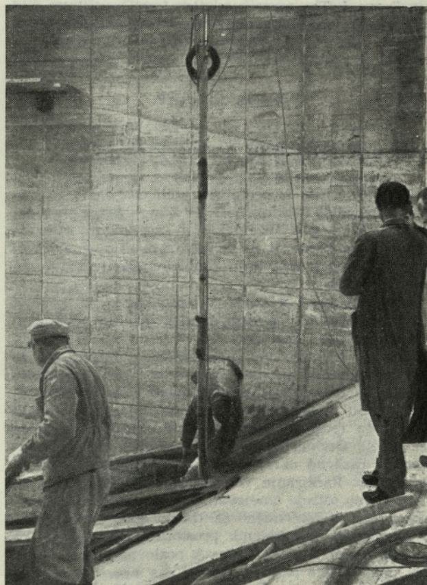
Sl. 3. Vlaganje cinkove anode v izvrtino
