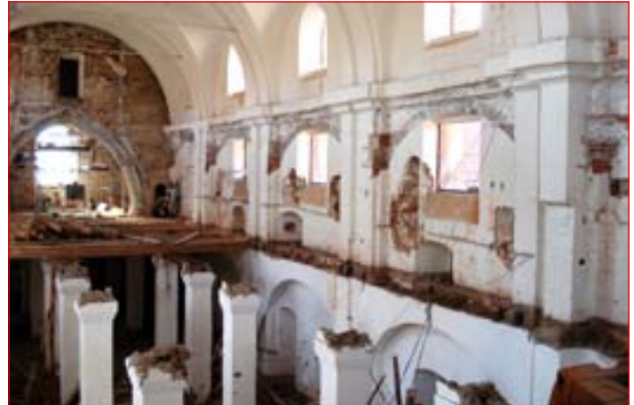
Cerkvena ladja med izvajanjem rušitve stropa v cerkveni ladji
