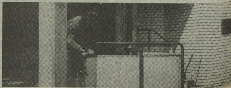
Še zadnja popravila in olepšave pred tehničnim prevzemom objekta A 26
