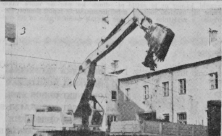
Med Lackovo in Trstenjakovo ulico v Ptuj je opravil mali žerjav ogromno delo za novo poslovno stavbo. — Izpraznil je jamo za kletne prostore in za temelje
