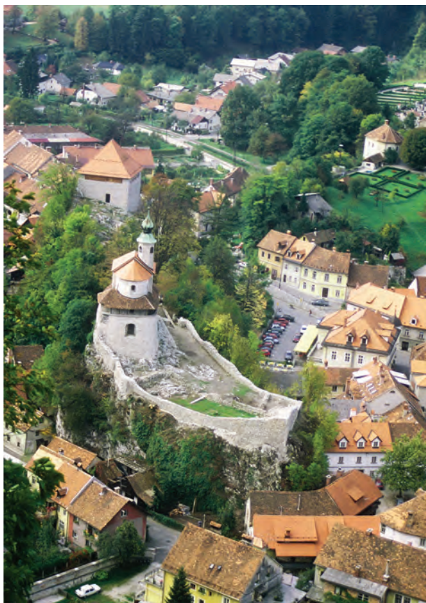
Slika 2. Sanirano obodno zidovje, kapela in stolp na Malem gradu 2004 (foto: M. Sagadin).
