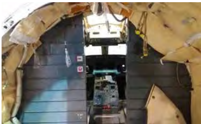
Slika 3 : CRJ 700, ko je sneta prva kuhinja in omara, predno se izvede pregled strukture
