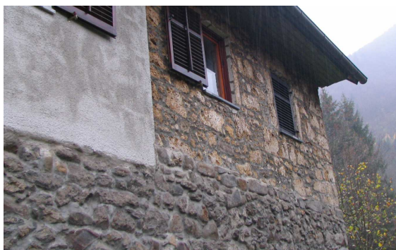
Slika 252: Zunanji izgled hiše na Hribce: ometani del levo je stena hiše, v osnovi izdelana iz tesanih gred, desni del nadstropja - štiblc je zidan iz luknjičastega in izolativnega lehnjaka, spodnji iz na vlago odpornejšega peščenjaka.
