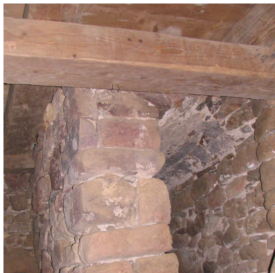
Slika 226: Baba z malim obokom desno in lesene grede stropne konstrukcije v prvotnem hlevu.
