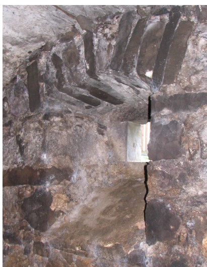
Slika 238: Detajl natančne notranje obdelave okenske odprtine v kleten prostoru; Jurinava hiša v Mandlih.
