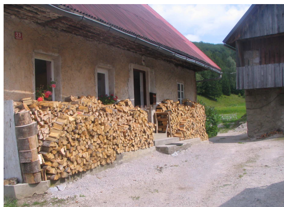
Slika 69: Večji napušči nad vhodno ali dvoriščno stranjo so bili pogosti, zaradi zaščite vhoda in prostora za drva.
