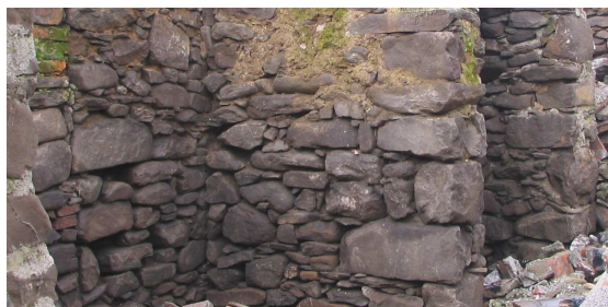
Slika 44: Kamnita stena, grajena iz izbranih in obdelanih kamnov z vsaj dvema vzporednima ploskvama in tretjo, pravokotno na njiju. Zidava je pri večjih stavbah poravnana z vogalniki. Struktura kamnitega zidu kleti iz peščenjaka podrte Jurkave hiše, Plešče.
