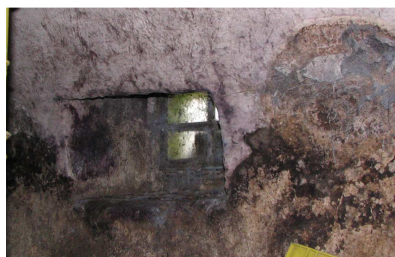
Slika 187: Plitvo polkrožno obokana in ometana klet v kvadratu dodanem pravokotniku. Spodaj detajl okenske odprtine od znotraj.
