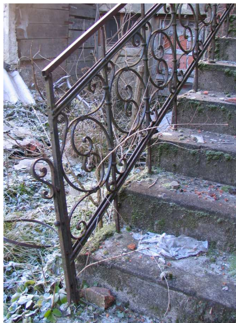
Slika 196: Nekdanja kovana ograja stopnic za na vhodni gank s sprednje strani hiše, sredina 19. stoletja. Ob predelavi hiše vgrajena na dvorišču Šučave hiše, Plešce.
