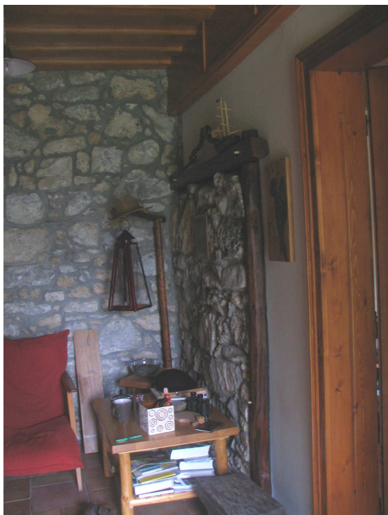
Slika 255: Veža s kamnitim zidom proti ognjiščni kuhinji in desno, kamnito nižjo steno, za katero je bila postavljena krušna peč v hiši.
