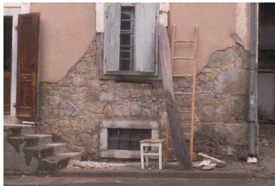
Slika 218: Sanacija spodnjih delov fasade v letu 1989.
