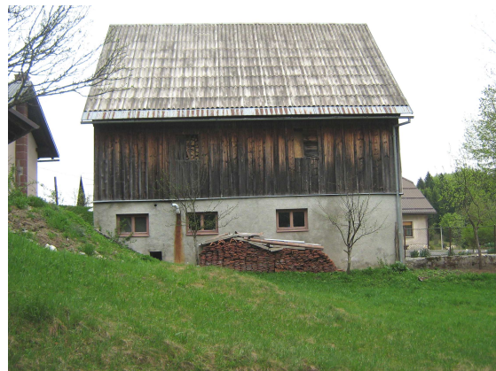
Slika 280: Skedenj s področja Trstja (Trščá), spodaj s kamnom pozidan hlev, zgoraj leseno nadstropje za seno.
