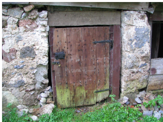
Slika 53: Vrata v klet vrhhlevne hiše, običajno so bila brez obočne preklade. Zakrajc Turkovski.
