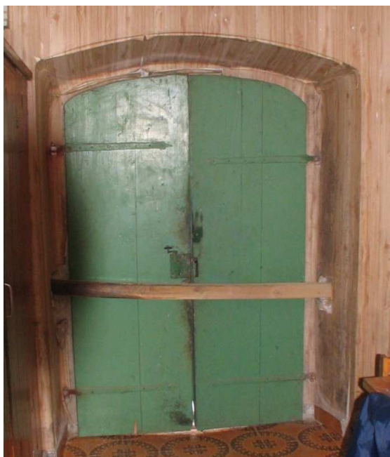
Slika 166: Vhodna vrata z lesnim riglom.
