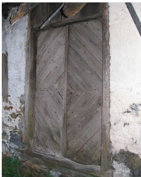
Slika 71: Dvojna zadnja vhodna vrata skromnejše hiše, letvičaste izdelave, Hrvatsko.
