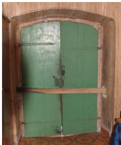
Slika 62: Notranja stran vhodnih vrat pri Tamažavih. z velikim lesenim riglom, skritim v steni, Plešce
