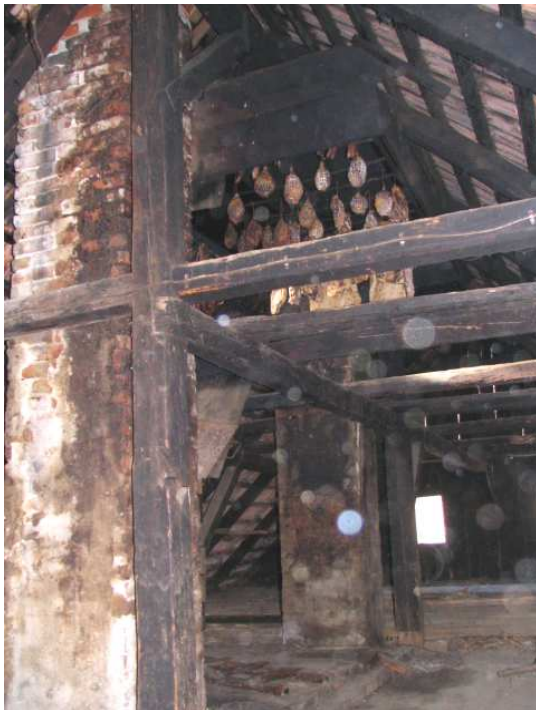
Slika 177: Podstreha z »novima« dimnikoma iz konca 19. stoletja in srednjo nosilno lego. V slemenu je na sušilu obešeno meso.
