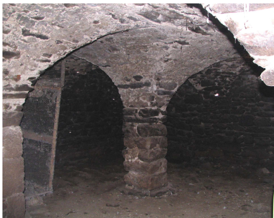
Slika 66: Hlevski prostor Jurinave hiše iz 1834, s štirimi stebri pravokotnega prereza v sredini in križnimi oboki, Mandli.
