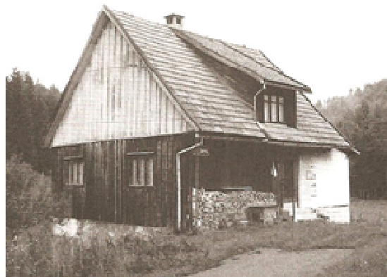
Slika 278: Tipična hiša iz okolice Trstja (Tršća), nekoč je bila brez frčade na strehi, brez dimnika in tridelnih oken. Vse to je bilo dodano kasneje. Streha je bila običajno na čop. Na srejde štalę je bua kamnita baba na kire je buo per starine uogniščę, a v novejeh cajteh so najne zezidale rajfnek.
