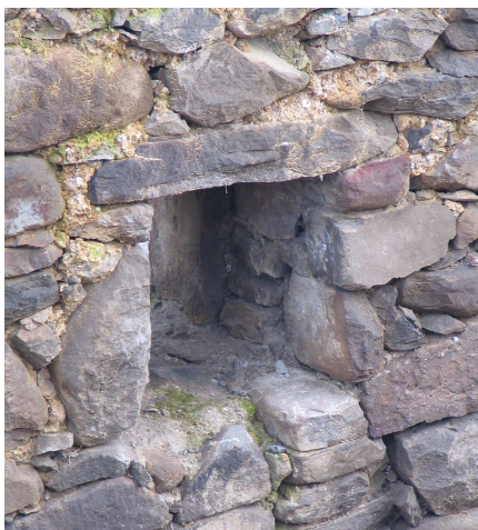
Slika 47: Detajl izvedbe male zidne niše v kleti podrte Jurkave hiše.
