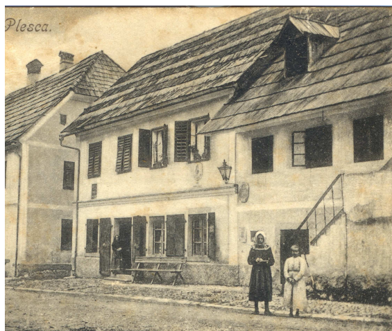
Slika 191: Desno stara Šučava hiša središču vasi, s stopnicami v nadstropje. Levo k njej je bila leta 1881 dozidana nova stavba trgovine.
