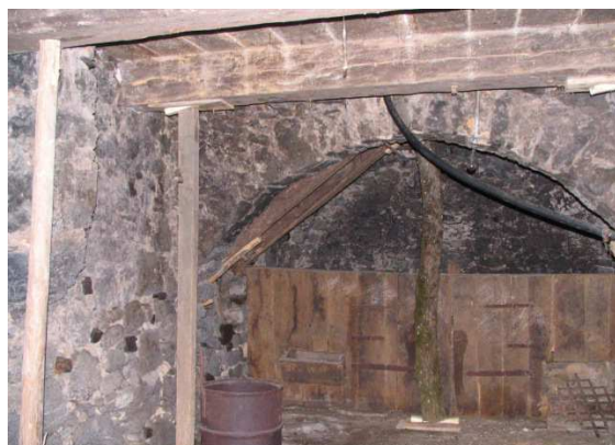
Slika 45: Spredaj lesen strop hleva pod bivalnim delom – hišo, zadaj lepo obdelani kamniti obok nad svinjskimi štalicami, za podporo ognjišču ter peči zgoraj. Grajska hiša iz 1821, Bosljiva Loka.
