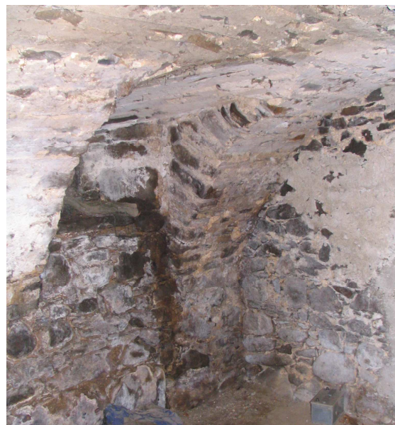
Slika 159: Na rimski način obokana klet prvega objekta, z zidanim stebrom, ki je nosil obok ob oknu.
