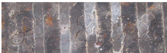
Slika 179: Detajl dekorativno obdelanega stropnega nosilnega tramu z vrezano letnico 1822.
