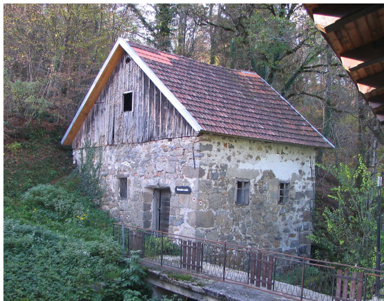
Slika 115: Tamažav maln , verjetno iz leta 1822, edina v celoti ohranjena namenska arhitektura mlina v dolini, kjer je nekoč delalo okoli dvajset mlinov, Plešče.
