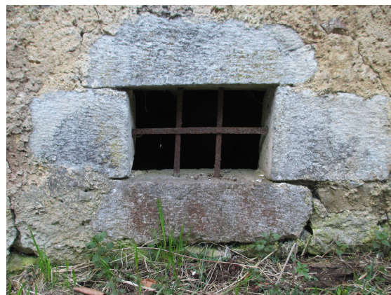
Slika 48: Detajl kamnitega okvira kletnega okenca, Zakrajc Turkovski..
