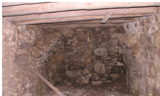
Slika 229: Ostanki delno podrtga oboka v zadnjem prostoru kletnega dela.
