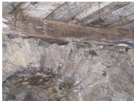
Slika 55: Detajl postavitve prečnega trama iz hrasta za lego debelih stropnih plohov proti hiši, na obokani del kleti – babo, Hrvatsko
