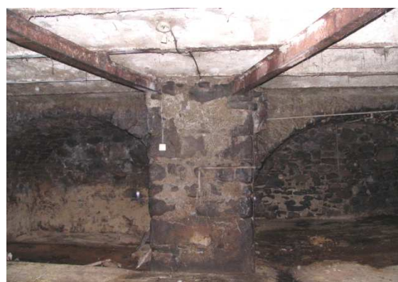
Slika 173: Široki središnji podporni zid v kleti – del štale z obokanima prostoroma levo in desno od babe .
