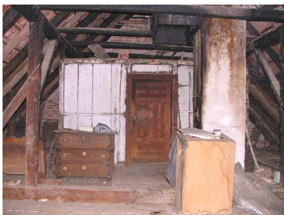
Slika 269: Pred drugo vojno iz plohov zbita podstrešna sobica, v notranjosti poletvana in ometana, nekdanj ogrevana z litoželeznim gašperčkom.
