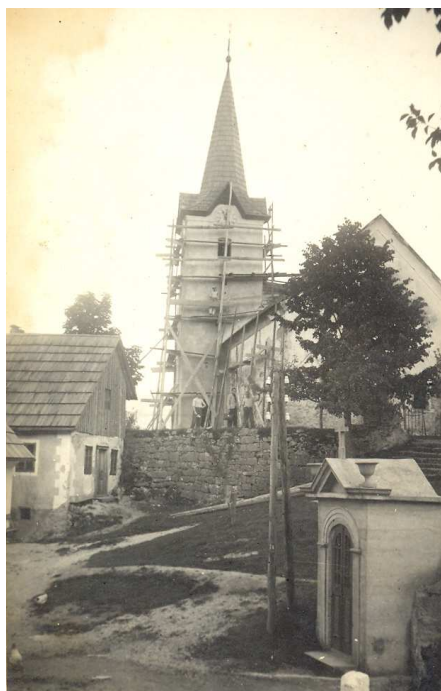
Slika 257: Fotografija cerkve na Travi pred drugo vojno, med vojno je bila v požgana in je danes le še ruševina.
