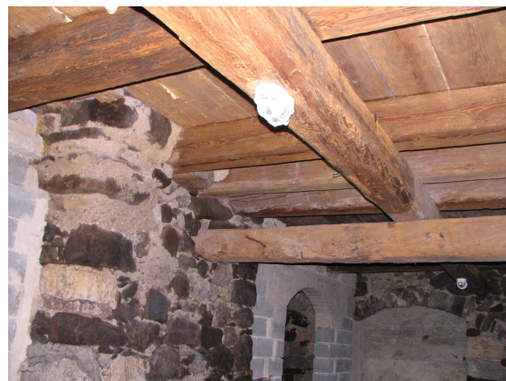
Slika 248: Močna jelova stropna konstrukcija v kleti hiše na Hribce iz začetka 19. stoletja.
