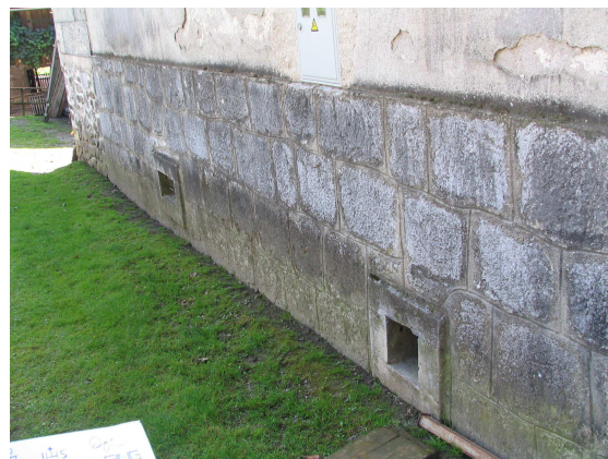
Slika 239: Lepo obdelan ves prednji del cokla Jurinave hiše iz apnenčastih blokov, z okviri kletnih okenc, Mandlih.
