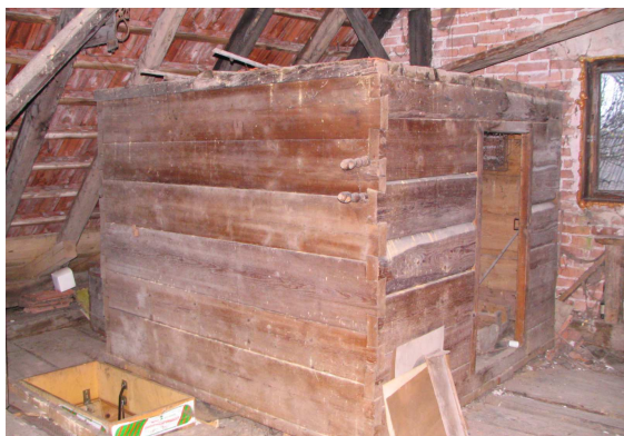
Slika 268: Stara kašča iz debelih plohov na lastavičji rep, s predali za zrnje in policami za drugo hrano v notranjosti.
