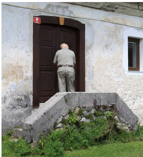
Slika 51: Leseni portal vhodnih vrat s kamnitimi stopnicami pred vhomom, Trava.
