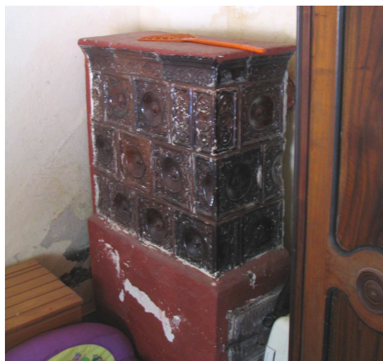
Slika 241: Iz ostankov pečnic nekdanje krušne peči sezidana pečica v Jurinavi hiši v Mandlih. Sosednji prostor, ki je že od začetka zanesljivo služil kleti za hrano, je
