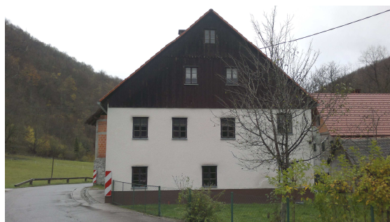
Slika 138: Pavlova hiša zgrajena 1855. leta s cestne strani, levo okence spodaj je originalne velikosti, ostala so bila ob predelavi pred drugo svetovno vojno povečana. V sredini inicialke gospodarja in leto gradnje. Spodaj pogled iz zgornje strani ceste. Desno je bila stavba dograjena, tam je bil prvotno verjetno le širok gank; ostrešje je bilo izvedeno na čop.
