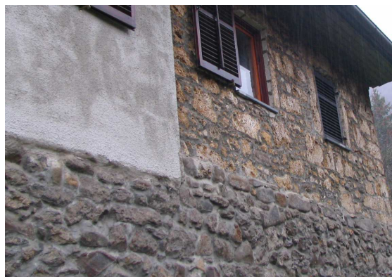
Slika 50: Spodnji hlevski del zidan iz peščenjaka, levo zgoraj leseno in ometano ostenje hiše, desno iz lehnjaka grajeni štiblc, Črni Potok.
