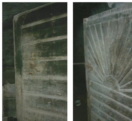
Slika 73: Še dve letvičasto obdelani vratni krili v notranjo klet iz leta 1865, vhoda sta na nasprotni strani pritlične veže, Črni Potok.
