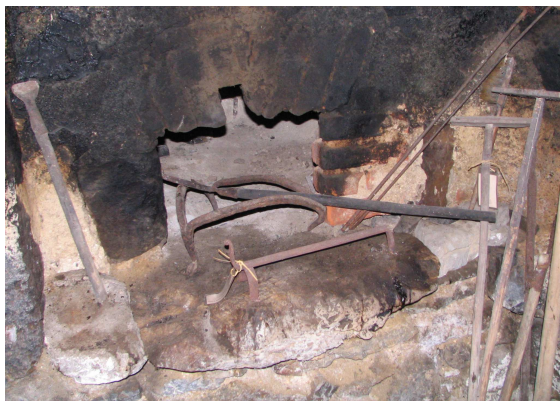
Slika 127: Pogled v odprtino za nalaganje krušne peči, s trinožnikom in zglavnikom.
