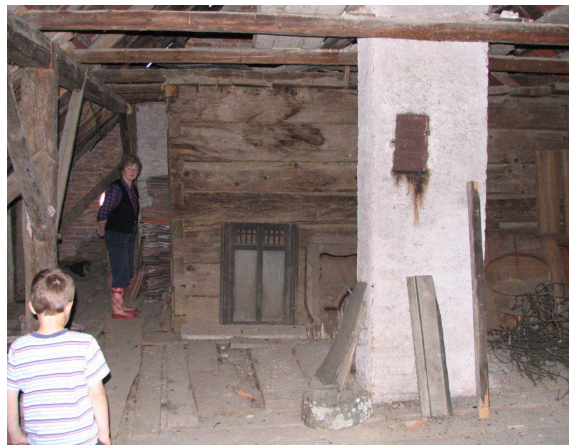
Slika 58: Velika kašča , velikosti 3x3m ločena od ostale konstrukcije hiše in zložena iz debelih plohov; na podstrehi Vrtnikove hiše v Osilnici.
