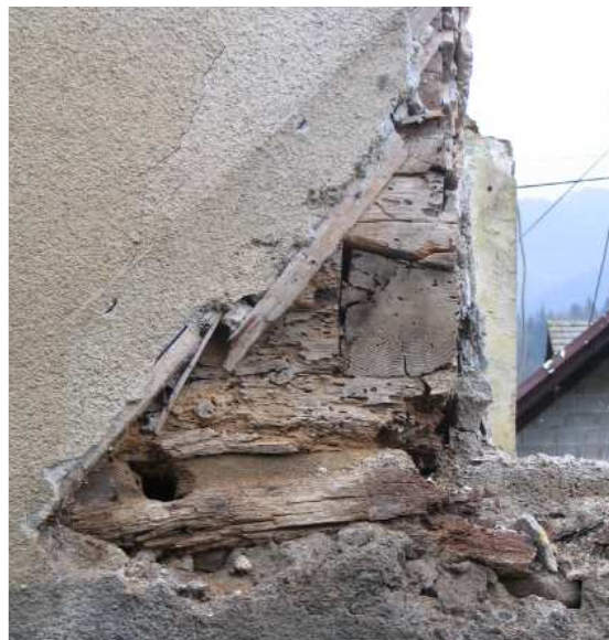
Slika 180: Detajl spajanja ostenja na lastavičji rep, na vogalu hiše iz 1822. leta.
