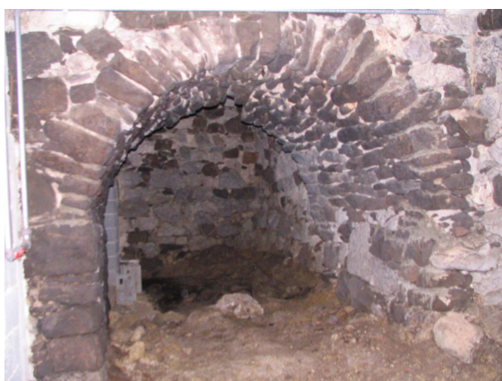
Slika 250: Detajl osrednjega polkrožnega oboka pod babo v kleti hiše na Hribce.
