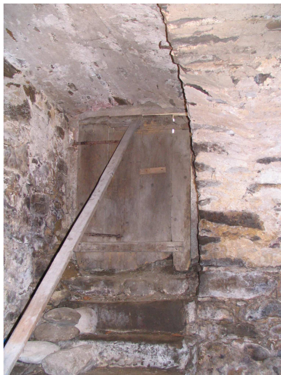
Slika 161: Nenavadno vzdani vhod v nekdanjo vinsko klet, proti cerkvi. Levi zid ni bil organsko povezan z ostalimi zidovi.
