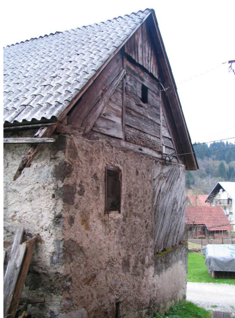
Slika 57: Kamniti zid, leseni bivanjski prostori s poletvanim in ometanim zidom, podstrešni del iz desk, sredina 19. stoletja, Hrvatsko.
