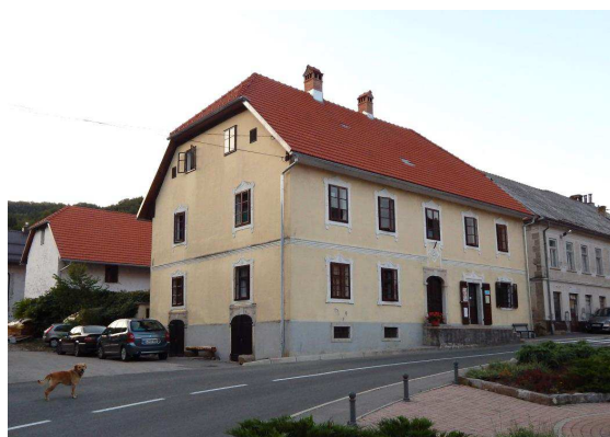
Slika 223: Palčava šiša in skedenj z novo streho, ponovno na čope, z obnovljenimi vhodnimi vrati ter novimi dvokrilnimi okni na šest šajb leta 2013.
