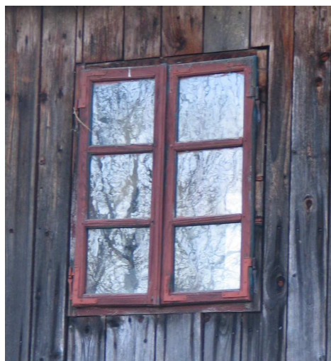
Slika 76: Dvokrilno okence v starih razmerjih, na šest šajb, s kovanim zunanjim okovjem iz časa pred drugo svetovno vojno, Požarnica.
