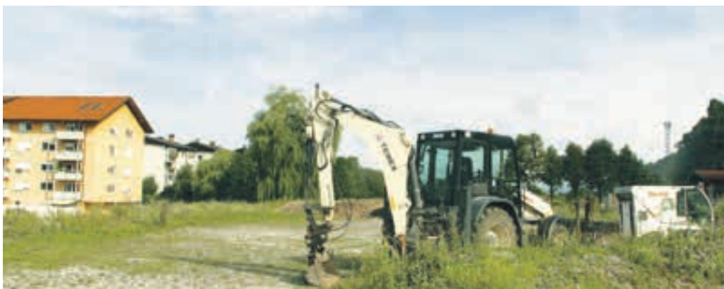
Prostor pred izgradnjo parkirišča
