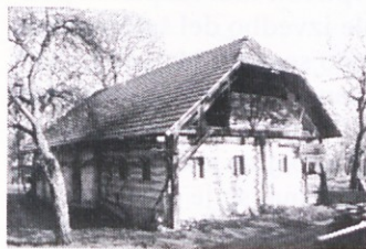
Kmečka hiša, stanje pred obnovo
