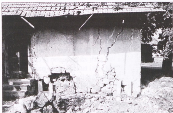
Kmečka hiša, detajl stene pred obnovo
