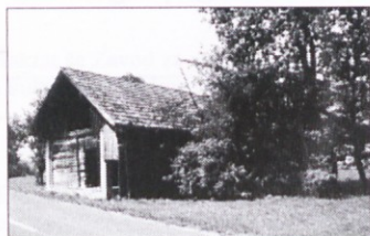
Kašča z vodnjakom, stanje pred obnovo
