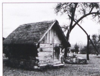
Kašča z vodnjakom, stanje po obnovi
