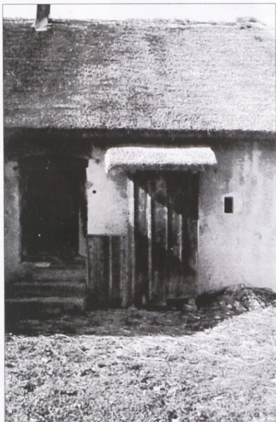
Kmečka hiša, detajl stene po obnovi.
