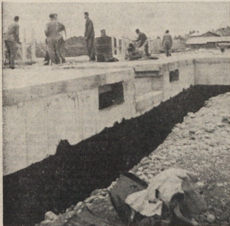
V Zalogu so že začeli graditi vrstne hišice
