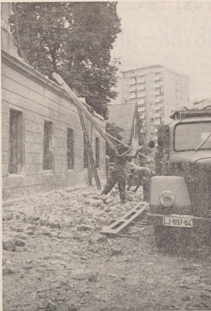
Na prostoru med Zaloško, Pokopališko in Proletarsko cesto, kjer bodo gradili družbeni center, že rušijo stare hiše
