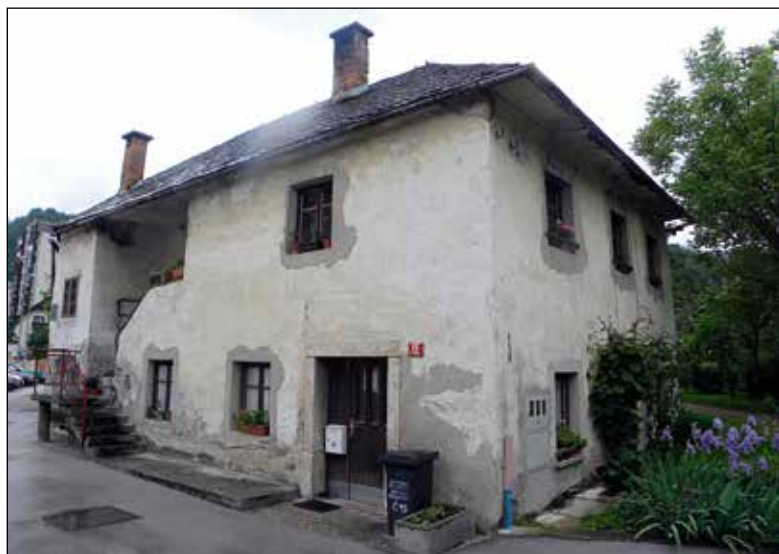
Hiša Češnjica 15 pred obnovo. Foto: Damjana Pediček Terseglav, 2010
