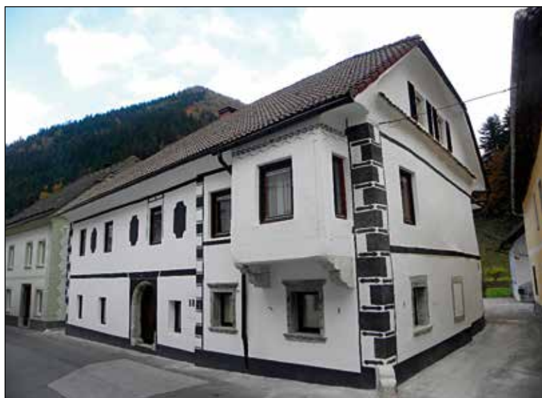
Bargl nova hiša po obnovi. Foto: Damjana Pediček Terseglav, 2011
