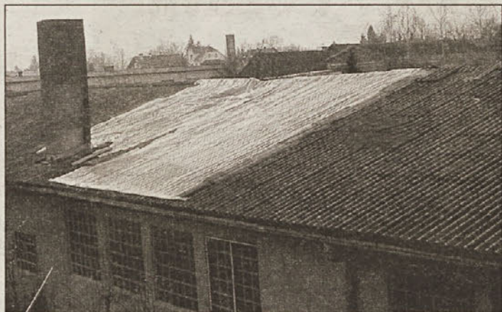
V prostoru 10 x 15m je zgorel strop in ostrešje, popokale so salonitne. Zgorelo ostrešje so začasno prekrili s polivinilom.
