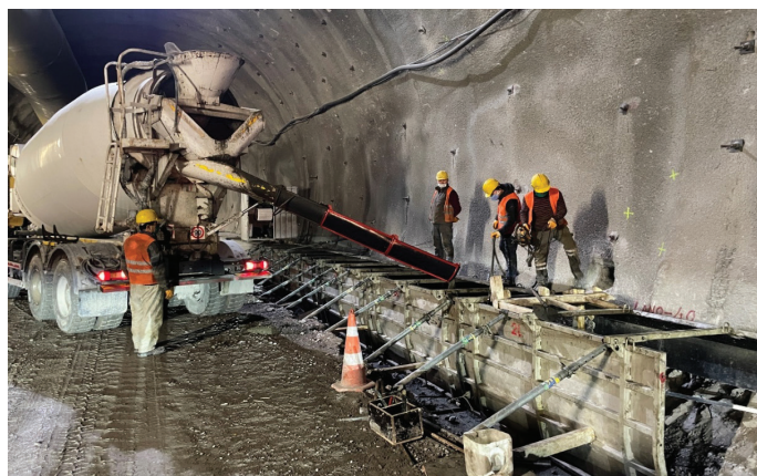
Slika 7. Betoniranje temeljev notranje obloge predora.
