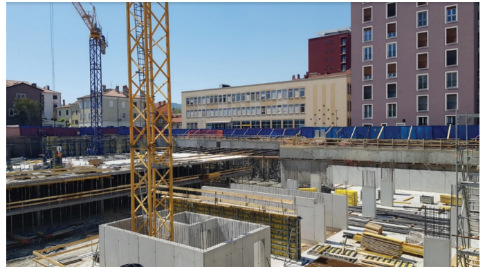
Slika 15. Pogled na gradbeno delovišče, april 2020.
