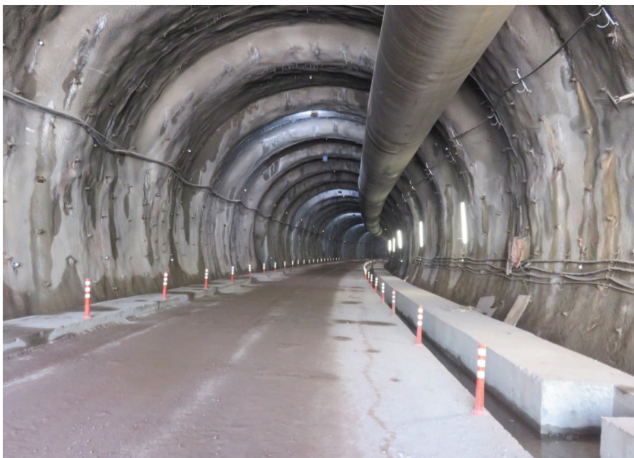
Slika 3. Pogled v predor z izvedenimi temelji in talnim obokom.
