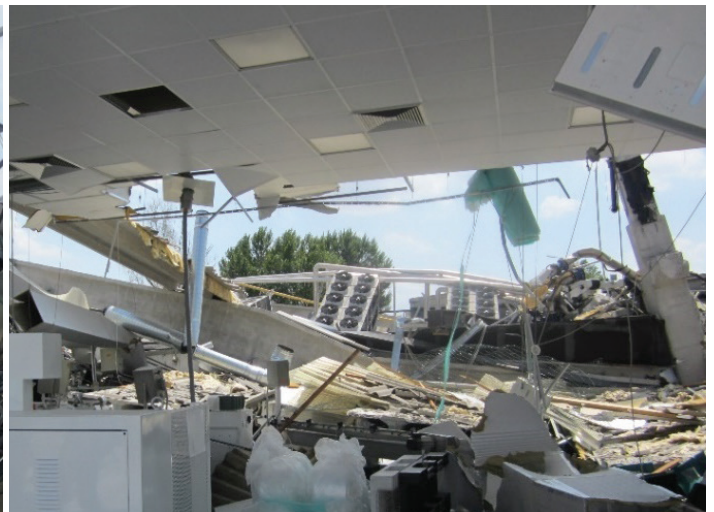
Slika 1. Glavni konstrukcijski sistem hale je razpadel, ker ni bilo mehanskih povezav med stebri in gredami.
