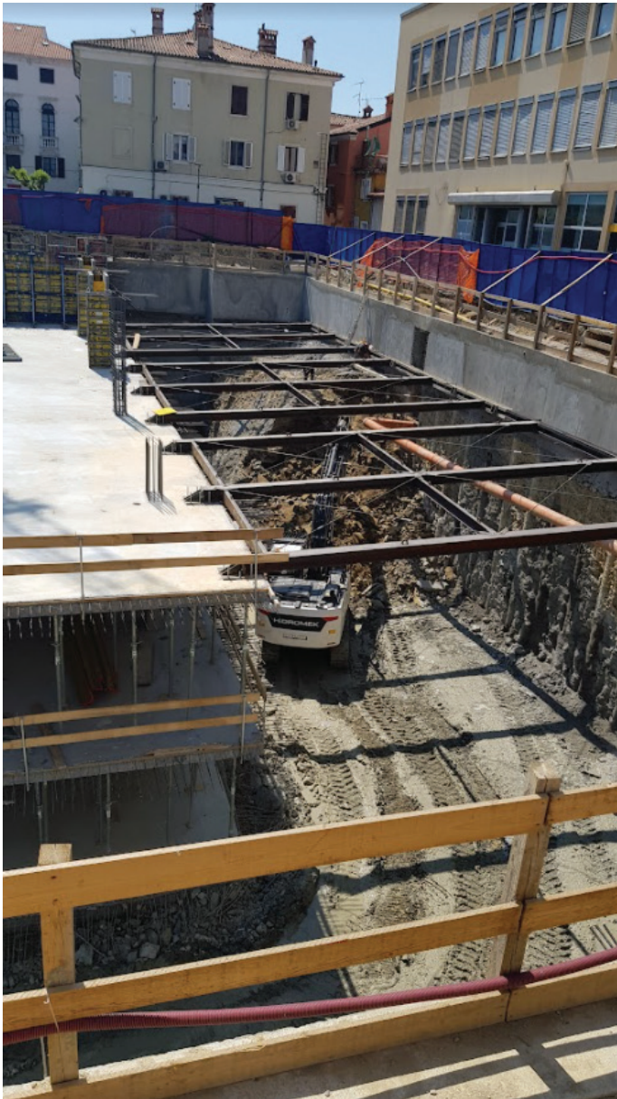
Slika 14. Razpiranje gradbene jame, april 2020.
