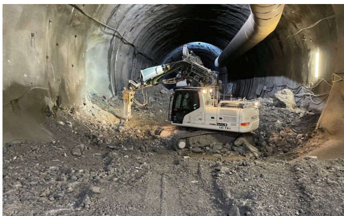
Slika 6. Izkop za talni obok iz brizganega betona.
