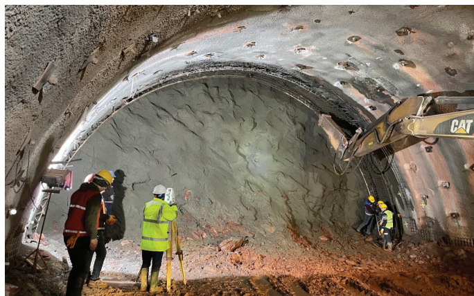
Slika 5. Montaža jeklenega loka (palični nosilec).
