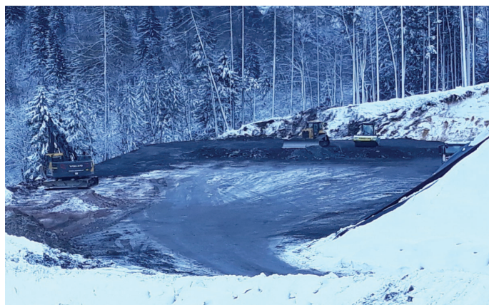
Slika 11. Vgradnja izkopanega materiala iz predora na lokaciji odlagališča 4 – Mojstrana.
