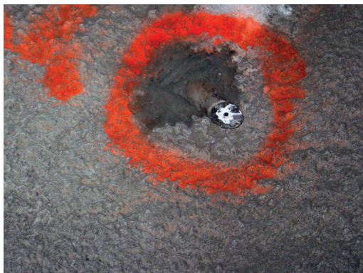
Slika 3: Stabilizacija merske točke v stropu in boku jamske proge.
