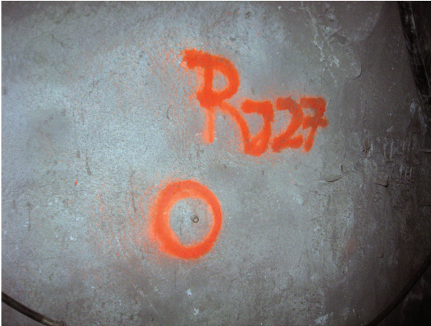
Slika 4: Izhodiščni reper RJ27 v jami.
