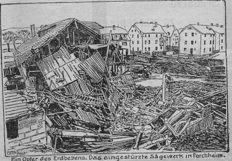
Ein Opfer des Erdbebens. Das eingestürzte Sägewerk in Forchheim.
