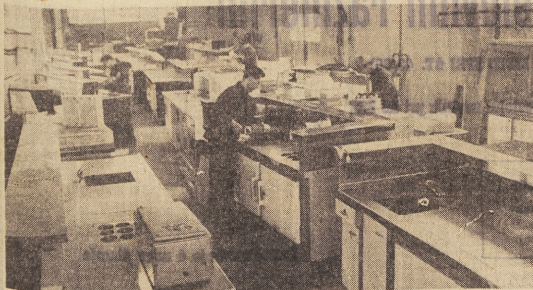
Delavci pri montaži hladilnih vetrin v obratu na Trati
