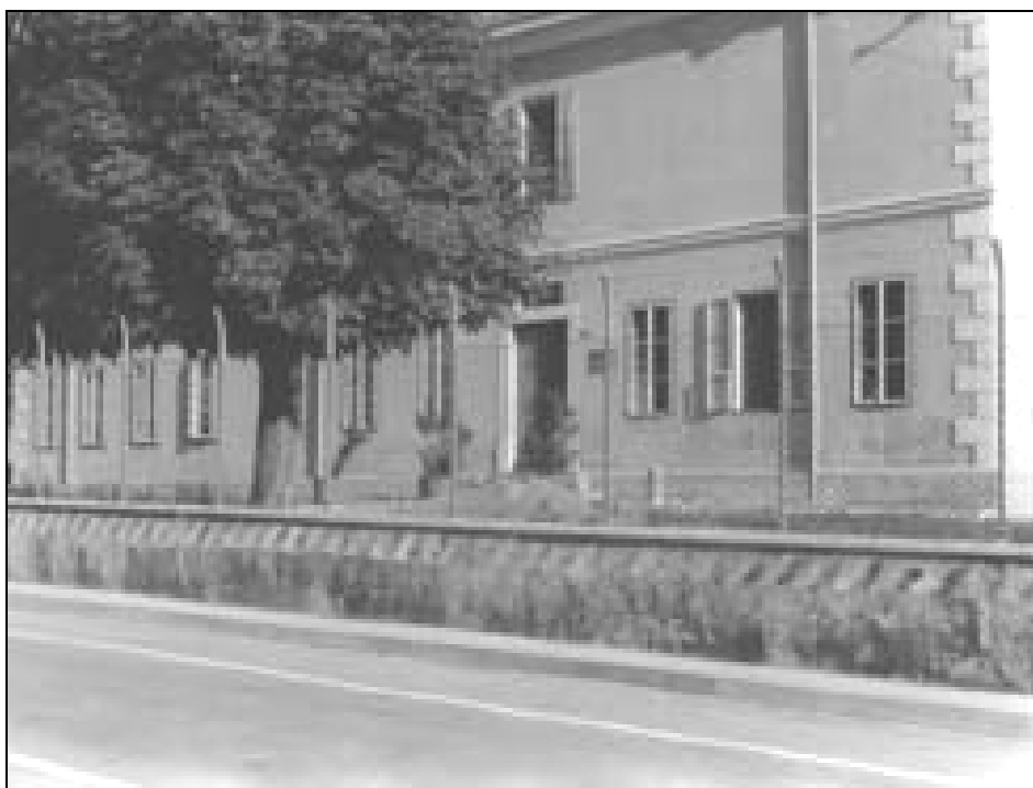
Srednja šola je delovala v stavbi nad križiščem, kjer se cesta iz Nove Gorice razcepi na cesto čez Col proti Idriji in tisto proti Vipavi in Postojni. V pritličju so bile ravnateljeva pisarna in stanovanje, kuhinja, knjižnica in nekaj učilnic. Ostale učilnice, vključno s prvim razredom srednje šole, so bile v nadstropju, kjer sta bili še zbornica in Matičičev fizikalni laboratorij.
