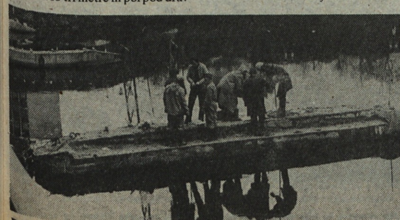
Priprave za miniranje stebrov starega pobreškega mostu v Mariboru
