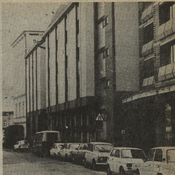
Novi del gledališčne zgradbe
