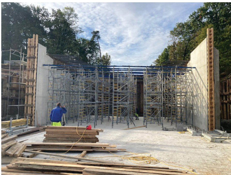
Slika 3. Postavljanje podporne konstrukcije za prekladno konstrukcijo (oktober 2021).
