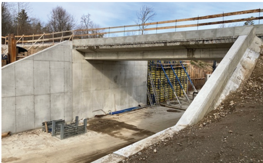
Slika 5. Zasip za kesonom z izkopnim materialom (februar 2022).
