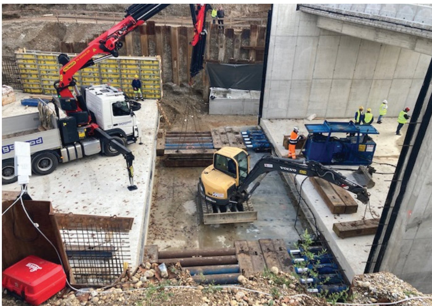
Slika 1. Potiskanje podvoza (november 2021).
