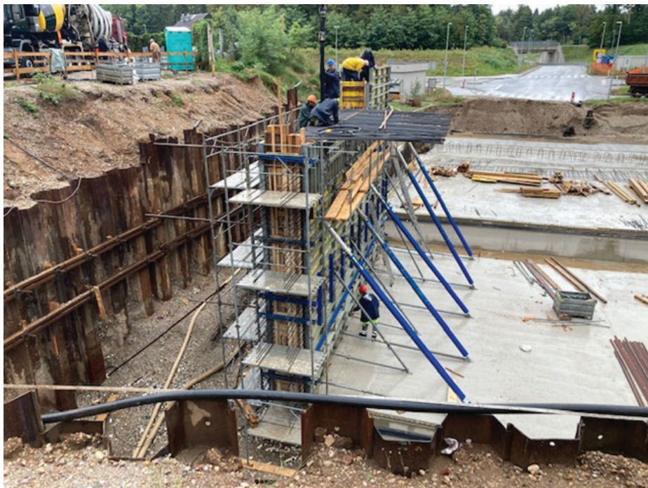
Slika 2. Postavljen opaz in betoniranje sten takta šest (september 2021).
