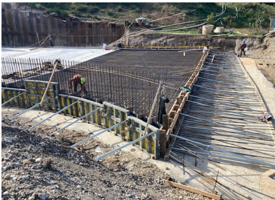
Slika 4. Armatura temeljne plošče (oktober 2021).
