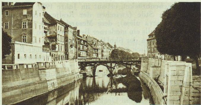
Hradeckybrücke mit neuem Quai.
