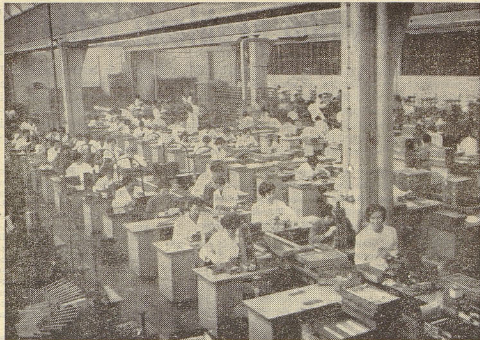
Iz montažne dvorane obrata avtomatskih telefonskih naprav v Kranju (k članku na 2. str.)
