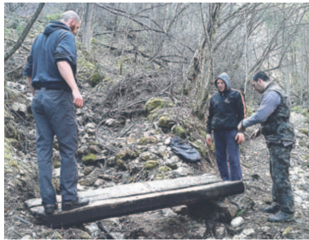
Prestavljanje mostička, ki ga je novembra preplavila Otavščica.
