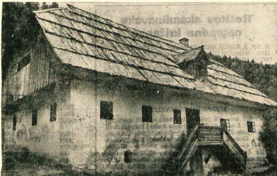
Izrazit jezerski kmečki dom — Krničarjeva domačija (Zg. Jezerjsko št. 104) pri starem Sv. Ožboltu. Hiša je še krita z macesnovimi skodlami, ograja stopnišča je lepo izrezljana, zidan je le spodnji del. — Foto: F. Perdan
