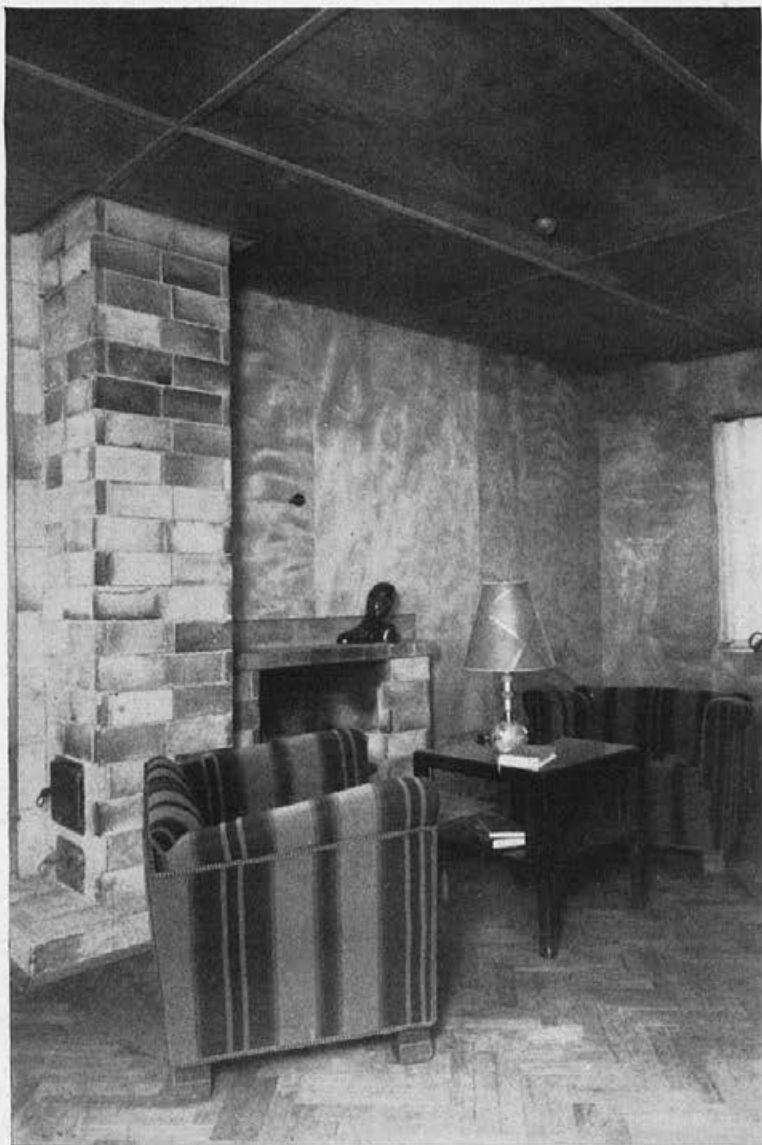
Arch. Ivo Spinčič, Ljubljana Soba gospoda Kamin: Šamotna opeka. Obloga: Okume. Mizarsko delo: Naglas, Ljubljana
