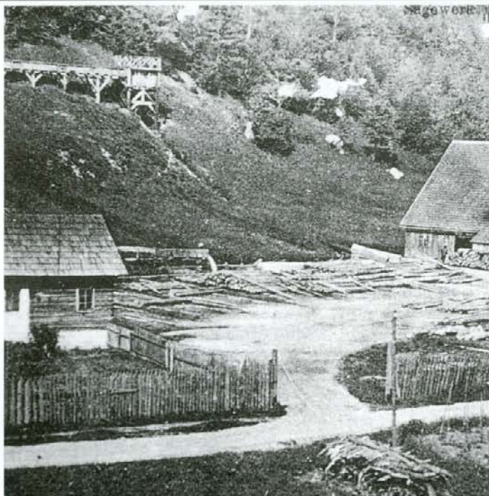
Žaga v Suhem dolu kmalu po začetku svojega obratovanja. V ozadju se vidijo leseni žlebovi in rezervoar za vodo, na levi strani pa pol lesena, pol zidana hiša z vrtom za žagovodjo in prevzemalca lesa. Slika je bila posneta najverjetneje enkrat v poletnem času, to se vidi, ker ni zalog hlodovine, ampak sam brusni les, ki so ga rabili za izdelavo lesne volne. Hlodovino pa so v glavnem vozili pozimi po sanincu.
