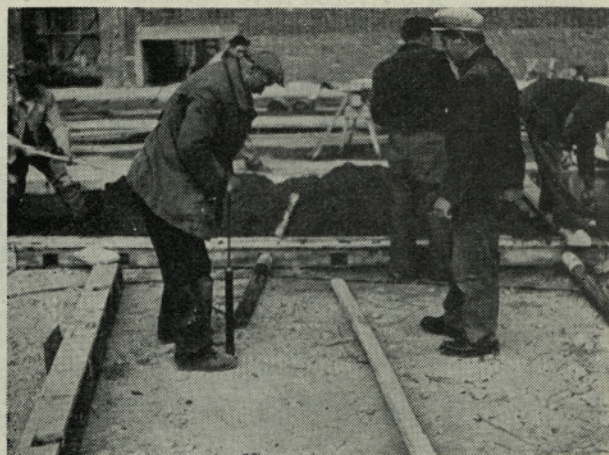
Polnjenje zračnic za kabelski kanal
